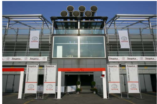
Ingresso palazzina box
